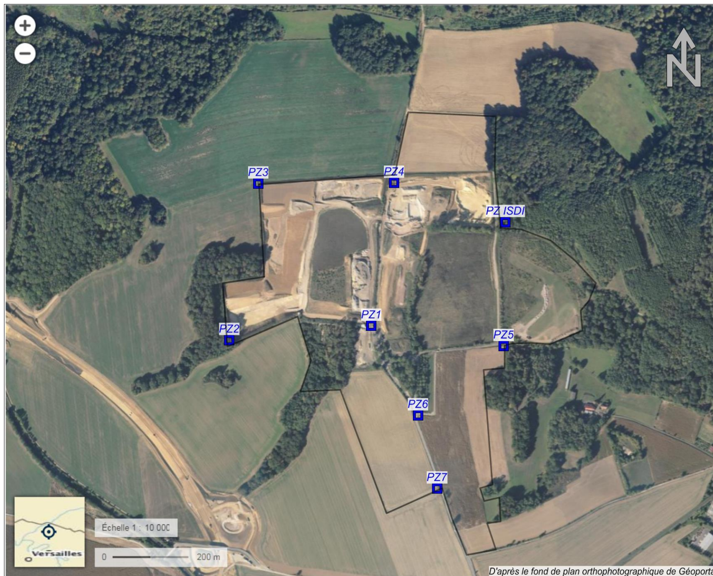
Figure 2. Réseau de contrôle piézométrique du site de Saint-Martin exploité par TERSEN (ACG).
